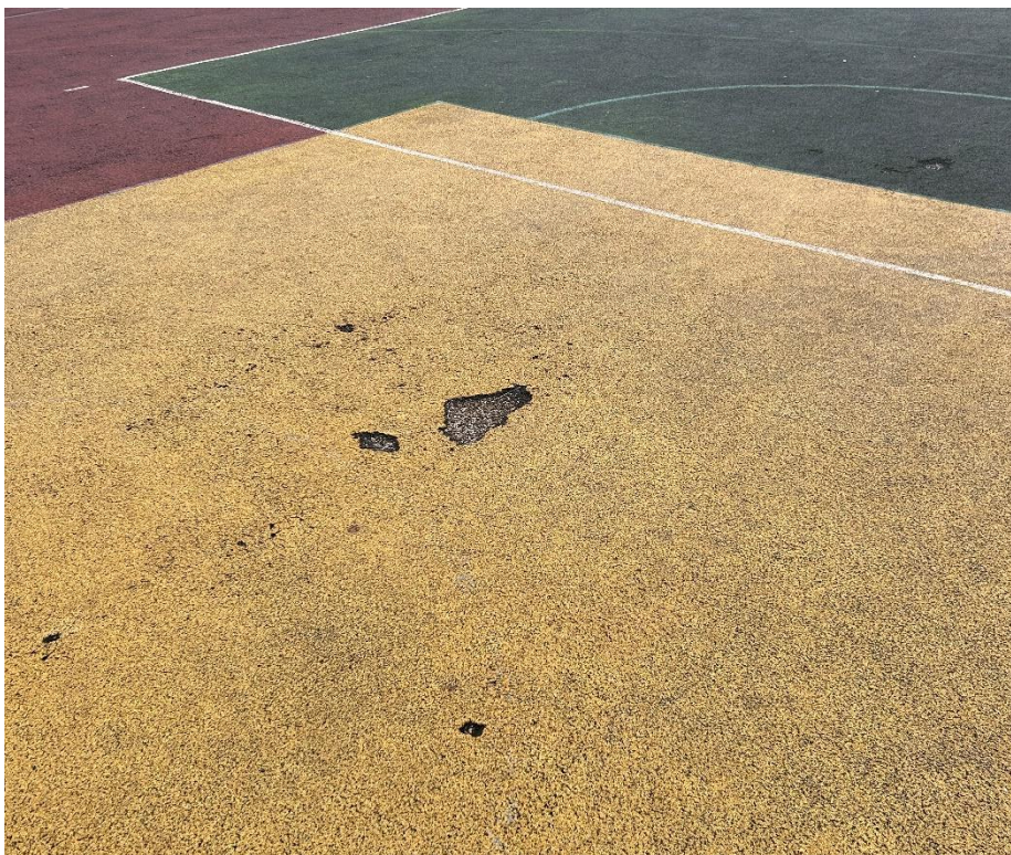
Fot 2 Uszkodzenia istniejącej nawierzchni
