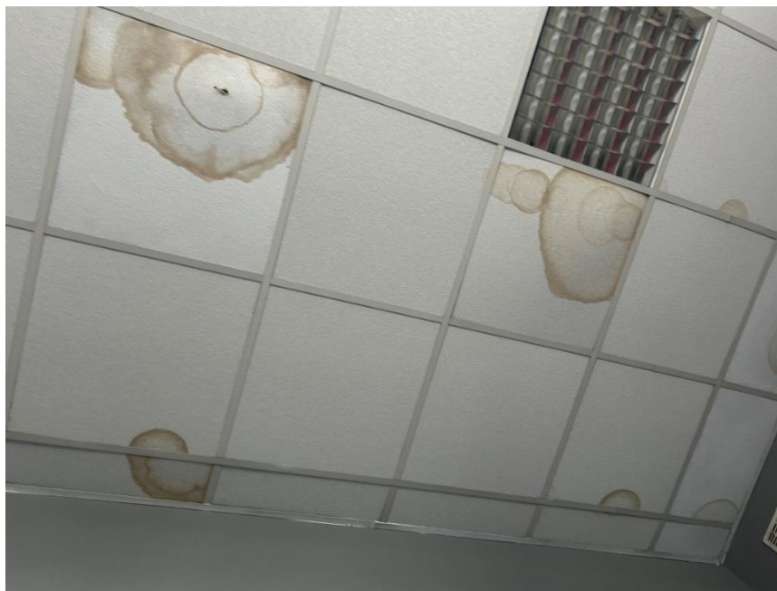
Fot 28 Fragment uszkodzeń sufitu podwieszanego w jednym z pomieszczeń siłowni na piętrze
