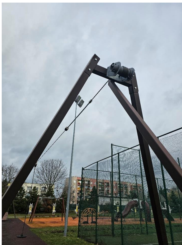
Fot 9 Skorodowane elementy zjazdu linowego
