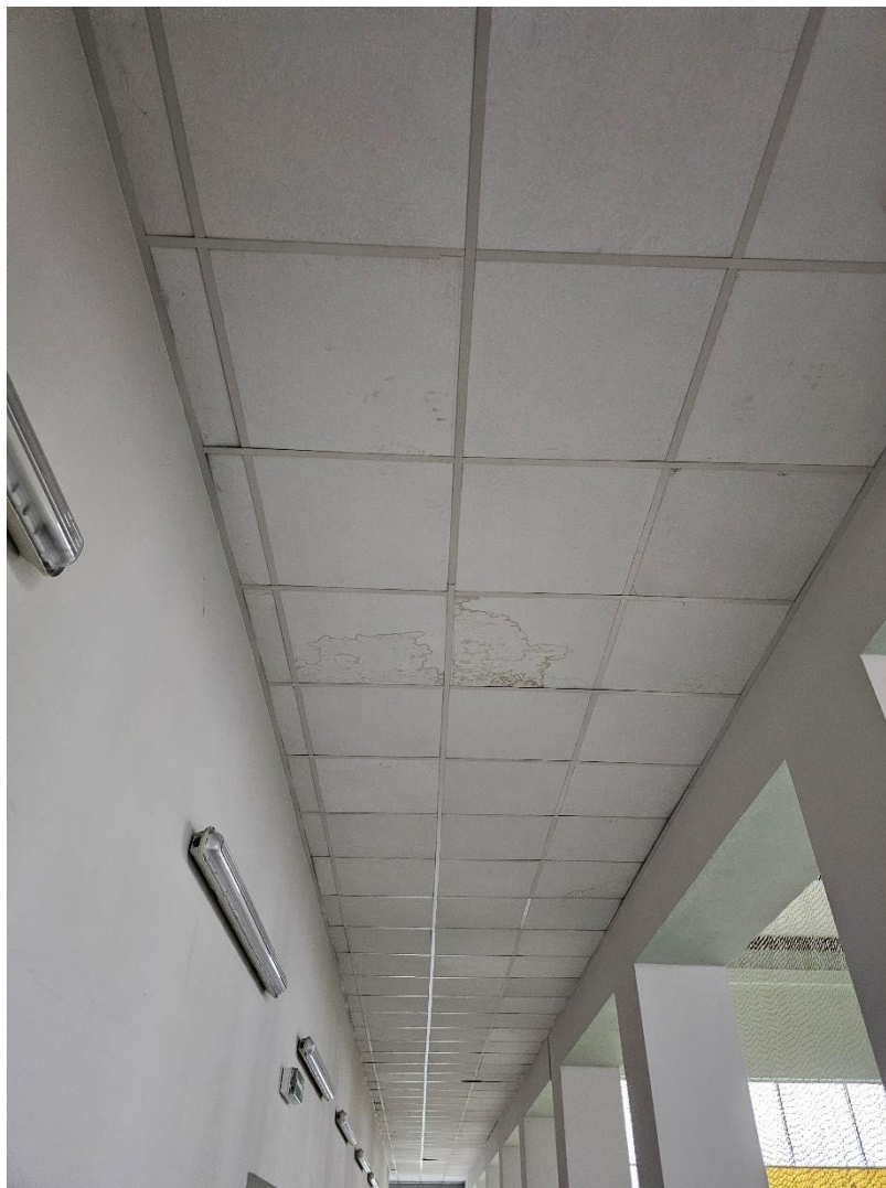
Fot 24 Uszkodzenia istniejącego sufitu podwieszanego w komunikacji
