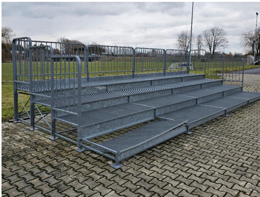
Fot 31 Konstrukcja trybun do wyposażenia w siedziska
