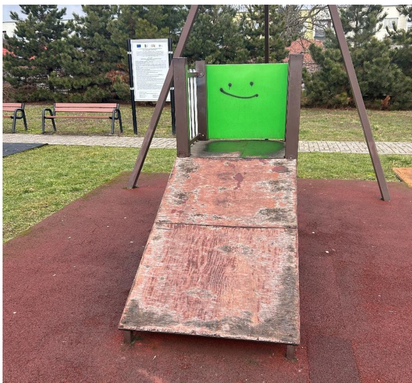
Fot 19 Podest startowy tyrolki do wymiany
