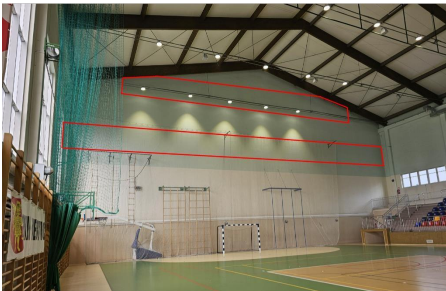
Rysunek 7 Widok ściany szczytowej hali, rozmieszczenie płyt gipsowo – kartonowych perforowanych, , płyty względem płyt na drugiej ścianie szczytowej montowane na mijankę
