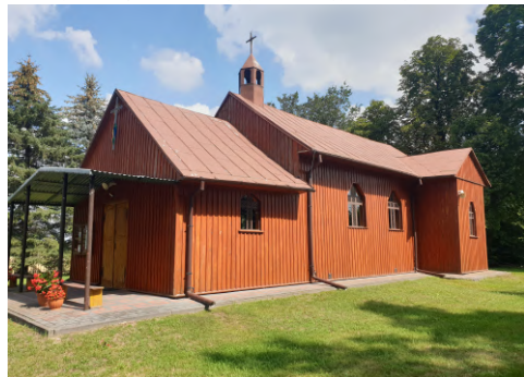
widok od str. południowej
